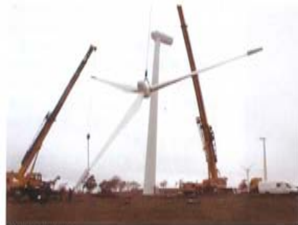
叶片吊装现场
