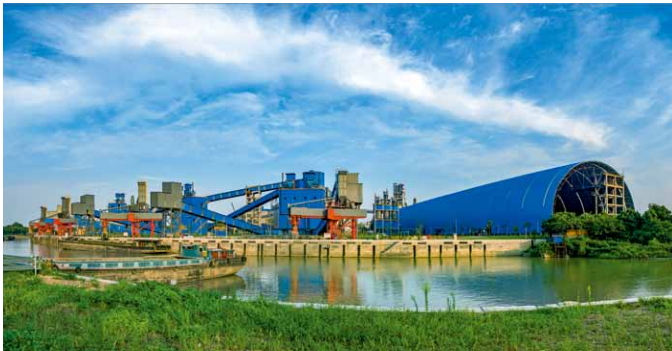
湖州南方物流有限公司码头全景
