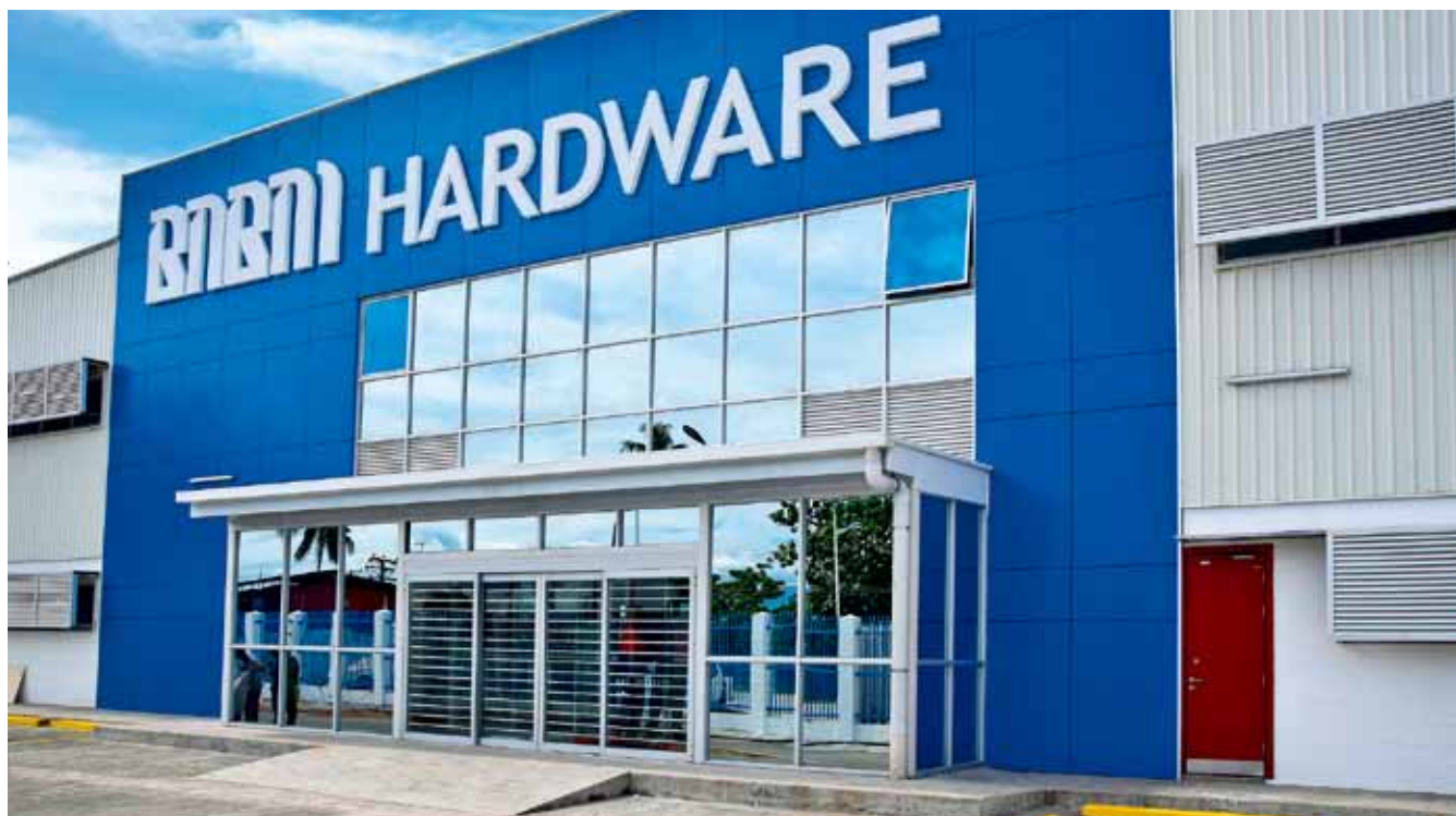
中建材投资巴新建材家居连锁超市
