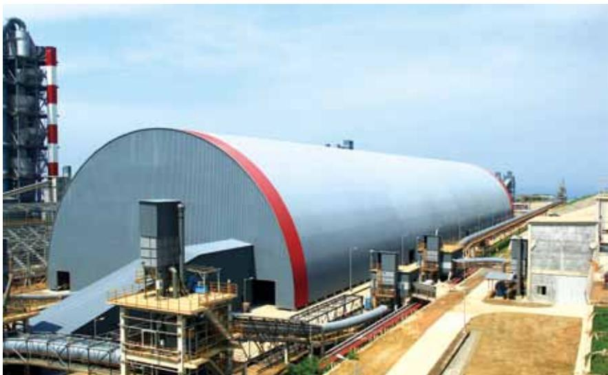
辅材原煤预均化堆场：钢结构跨度大，安装精准
